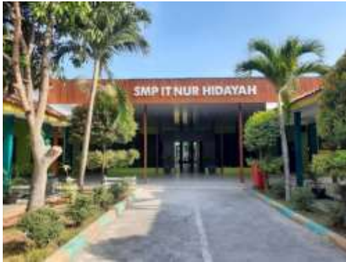
Gedung SMPIT Nur Hidayah Surakarta
