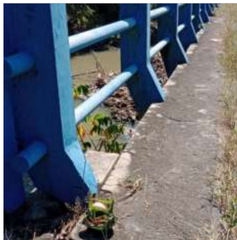
Gambar 3.2 Foto tempat peletakan tambangan di pinggir jembatan
