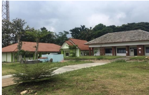
Lampiran 6 foto bangunan di LPKA Klas II Yogyakarta
