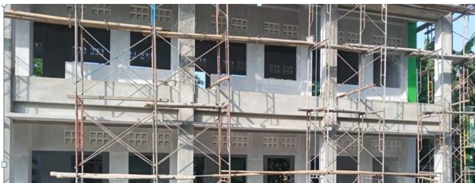
Gambar 4.2 Proses Pembangunan Kelas di KMI Ibnu Abbas Klaten (Observasi, 19-6-2023)
