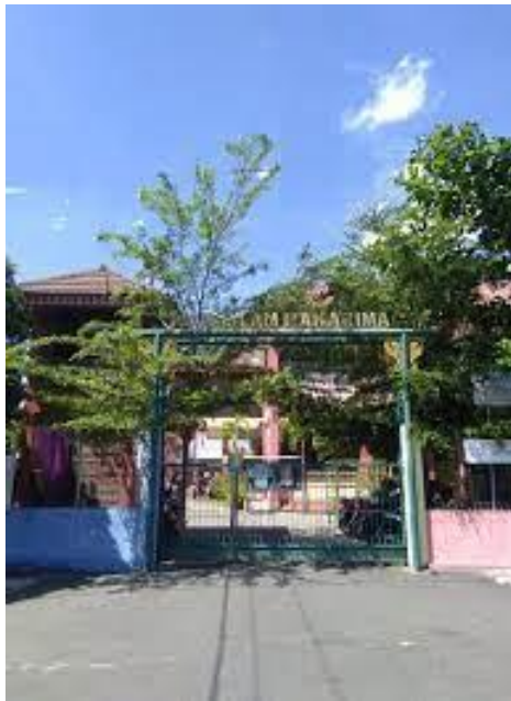
Gedung TK Islam Makarima
