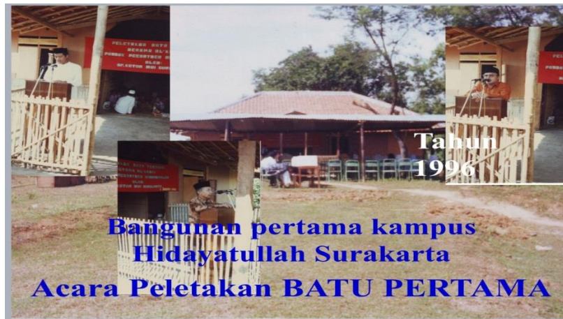
Gambar 3.7 Foto Bangunan Gedung Pertama Kampus Hidayatullah Surakarta
