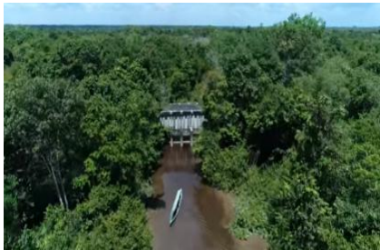
Gambar D15 Kanal Bendungan irigasi
