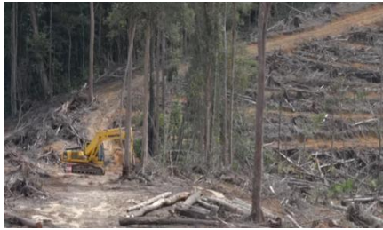
Gambar D17 Eskavator untuk pembukaan lahan
