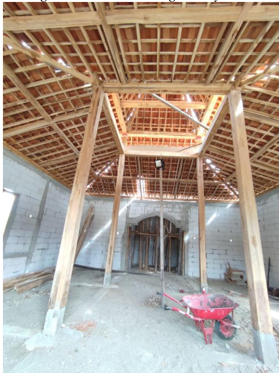
Pembangunan Mushola Dengan Kayu Perhutani
