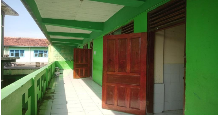
Gambar .5 Foto Ruang Kelas di Lantai 2
