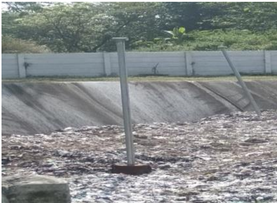
Lampiran 6 Gambar Landfill III dan Pipa Kontrol Gas Landfill
