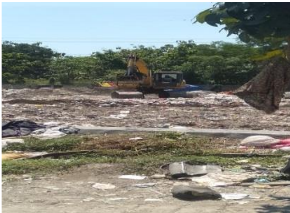
Lampiran 10 Gambar Proses Pengurugan Sampah dengan Tanah Urug
