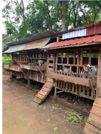
penampakan foto kandang kambing
