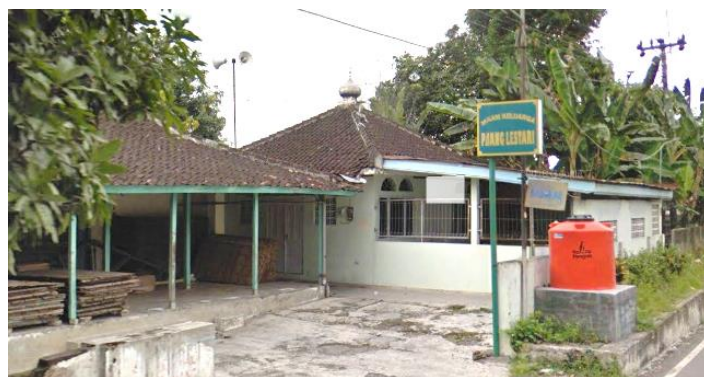
Mushola Barokah (2015) Sebelum Renovasi.
