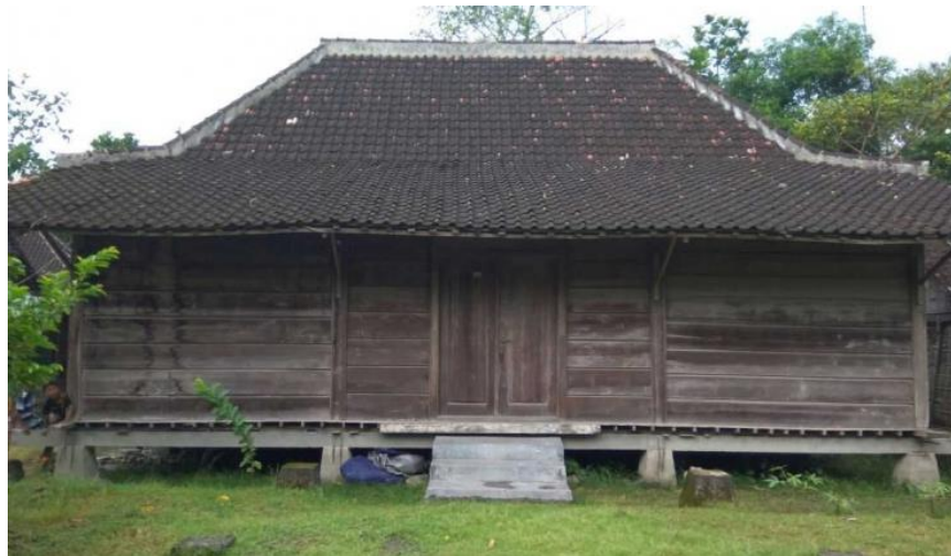
Gambar 2.3 Gambar Ilustrasi Bangunan Gladak
