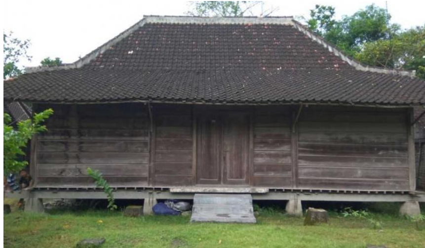
Gambar 3.1 Gambar ilustrasi bangunan Gladak
