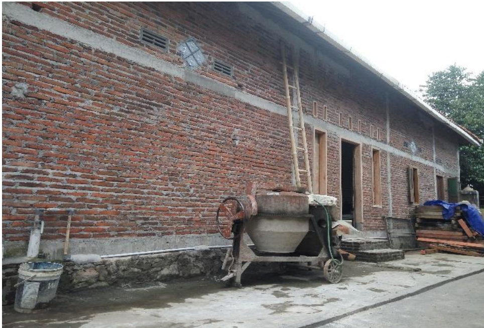
Gambar 4.5: Mesin sewa setelah digunakan dalam pembangunan.
