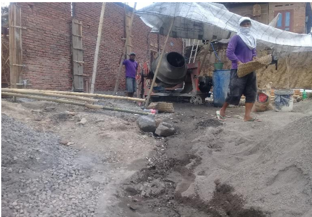
Gambar 4.4: Aktivitas pembangunan di lapangan dengan mesin sewa.
