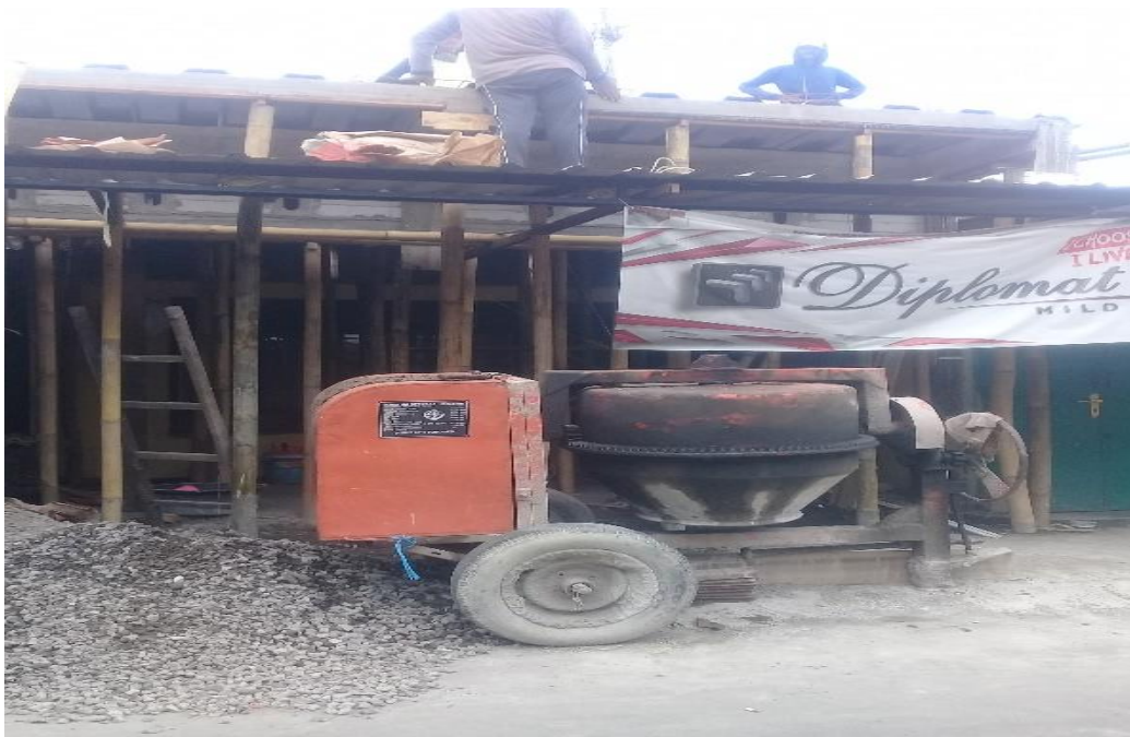
Gambar 4.3: Aktivitas pembangunan di lapangan.
