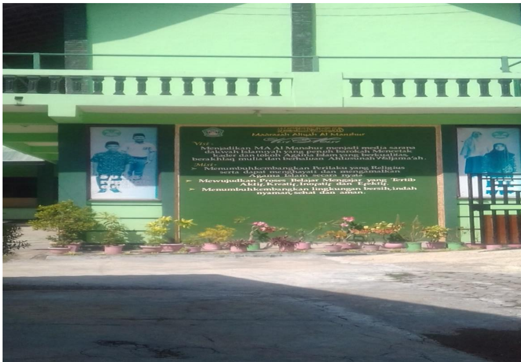
Bangunan Tampak Depan
