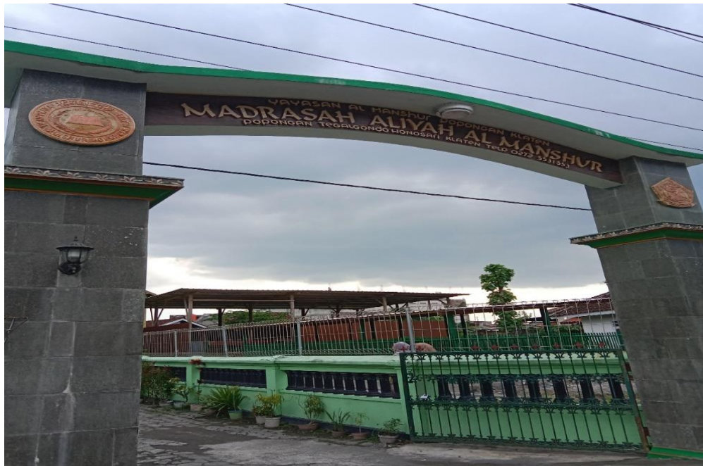
Bangunan Tampak Depan
