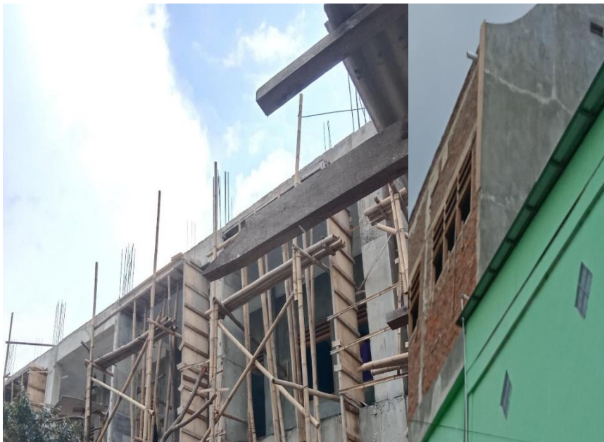
Pembangunan Laboratorium IPA di Gedung lantai 3
