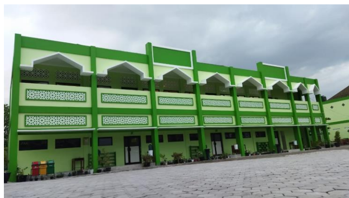
Gedung SDIT MTA Sukoharjo Tampak Dari Belakang
