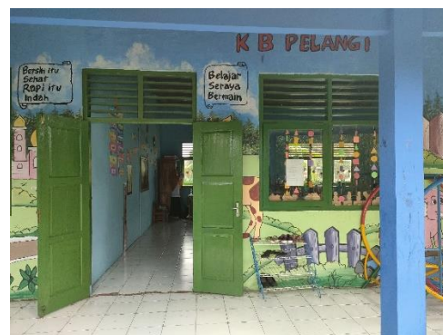
Ruang kelas KB Pelangi tampak depan
