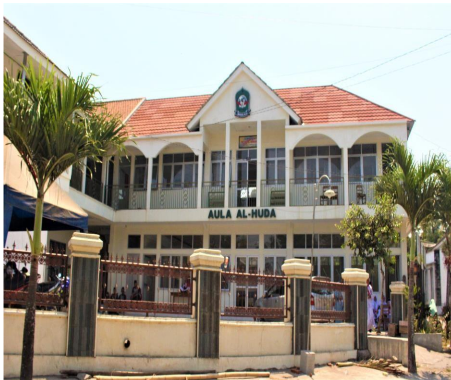
Potret gedung Aula Al Huda sebelum direnovasi
