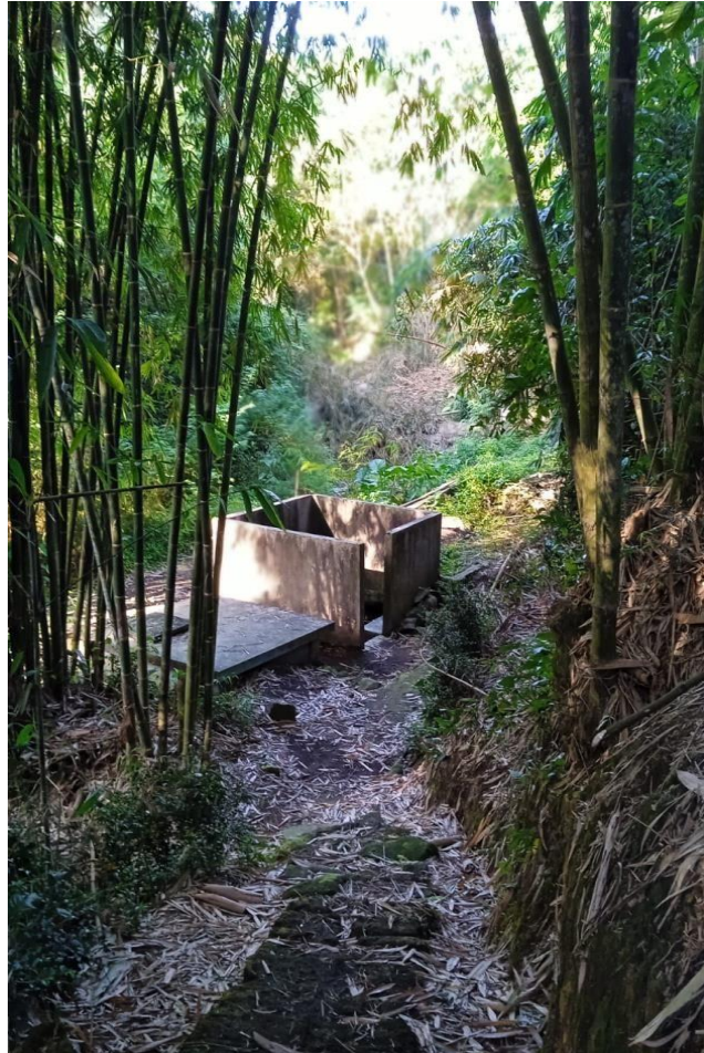
Penampungan air dari sumber air Kedung Mayit
