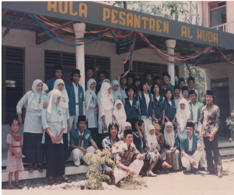
Potret gedung Aula Al Huda sebelum direnovasi
