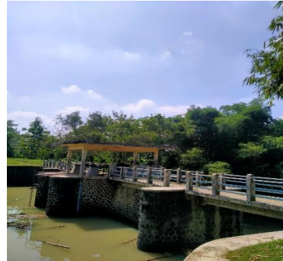
Dokumentasi terdapat sungai untuk akses jalan
