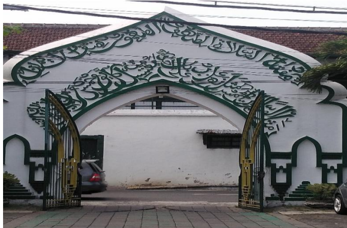
Gambar 3. 17 Gambar Gapura Depan Masjid Al Wustho terlihat dari belakang tahun 2013 M
