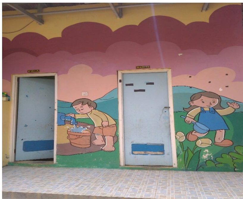
Dokumentasi Kamar Mandi TK 02 Munggur
