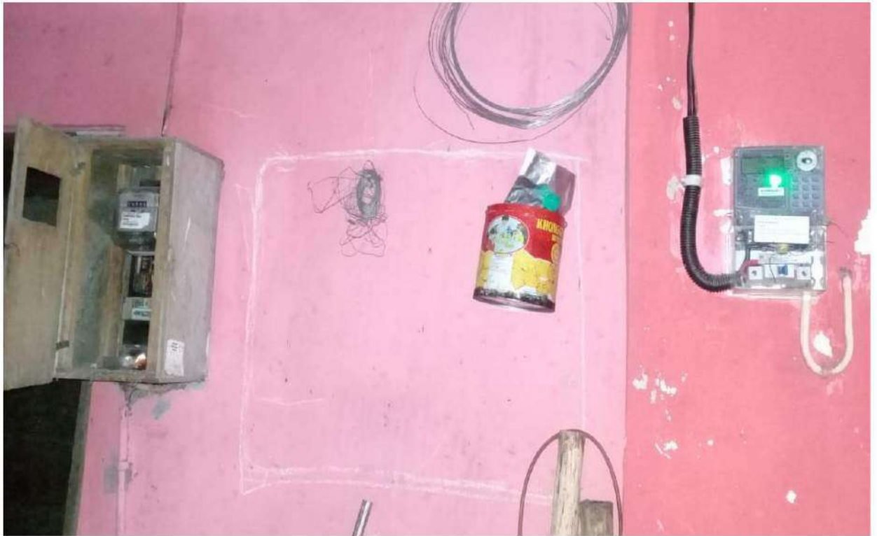
(Foto 1 : dua kwh meter listrik yang terpasang pada rumah pembeli)
